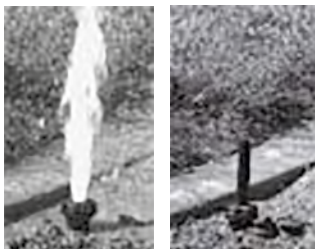
Sin el dispositivo de cierre de caudal
