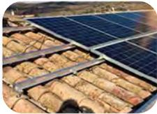
**Estructuras autoportantes** que se sujetan en la propia cubierta o en las correas de la misma, son **utilizadas en cubiertas ligeras o en cubiertas inclinadas** en las que la dirección (orientación /inclinación) de la cubierta es la adecuada.
