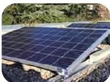
**Estructuras elevadas** utilizadas especialmente **sobre cubiertas planas de edificios, en los que no es posible fijar las estructuras mediante tornillería**, por ello se utilizan como medio de fijación piezas de hormigón que actuaran de contrapeso de la estructura como consecuencia de su peso.
