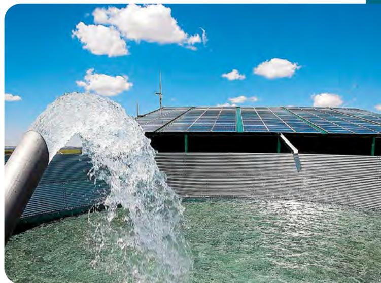
En nuestra latitud **la posición más adecuada para las placas fotovoltaicas** de una instalación autónoma **será una orientación sur** y una **inclinación de 50°** (favorable para la producción invernal) y sin sombras.
