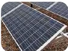
Estructuras **para instalación en suelo o cubiertas planas**, con una disposición elevada que **permitirá orientar las placas** en la posición adecuada, esto requiere un espacio entre hileras para evitar la proyección de sombras sobre los paneles, con la consiguiente aumento de la superficie ocupada.
