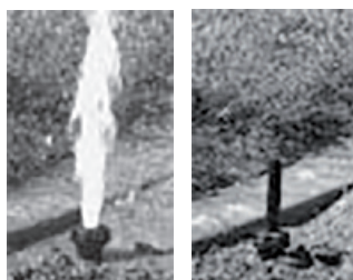
Sin el dispositivo de cierre de caudal
